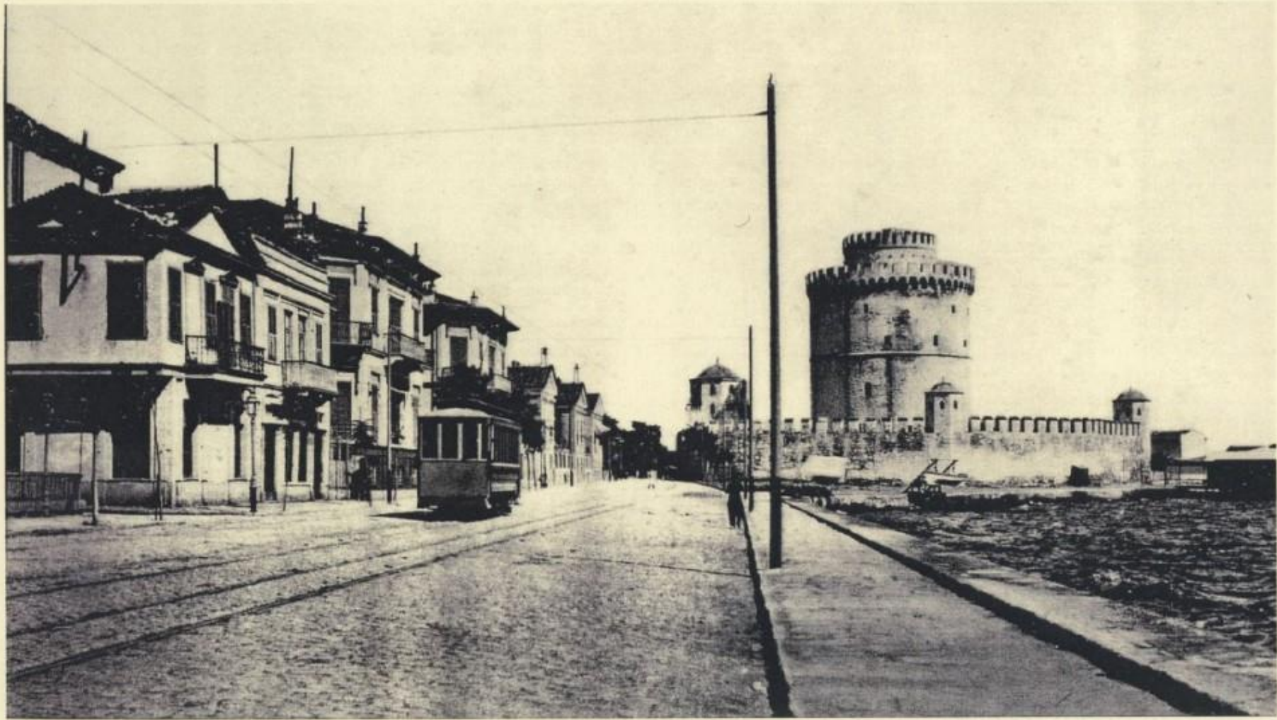
AVENUE de la TOUR BLANCHE
